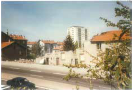
Démolition des maisons rue de Solaure — 1997 Collection J.B.
