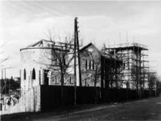
Église Notre-Dame de la Paix en construction – 1940-1944 Archives Evêché de Saint-Étienne Collection J.B.
