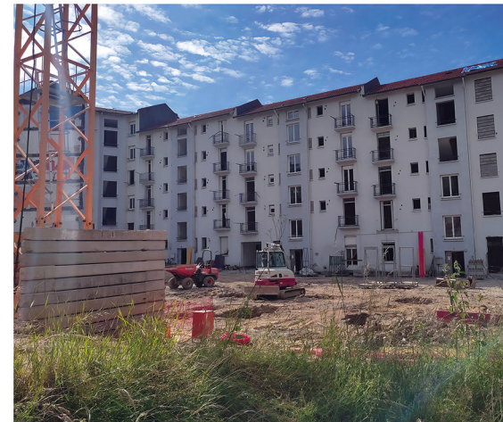
Les travaux rue du Président Mazarick – juin 2024 Archives du Centre Social
